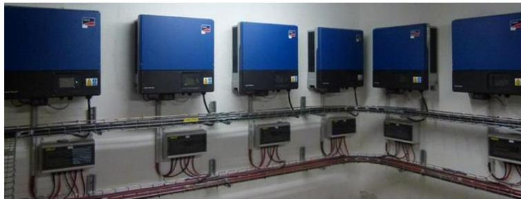
Chaque onduleur sera associé à une protection rapprochée contre les surtensions atmosphériques. En fonction du matériel, ces protections sont intégrées aux onduleurs, ou nécessitent l'adjonction d'un coffret électrique positionné à proximité immédiate des appareils.
